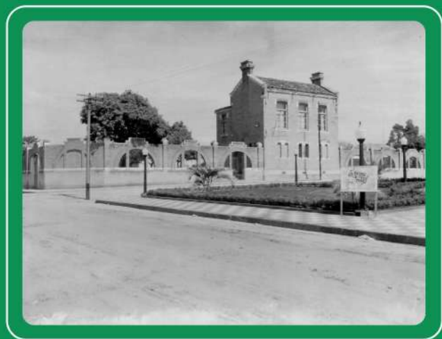
Localização: Rua João Lino, 371 Santa Bárbara d'Oeste Tombamento: Decreto municipal nº 6886, de 29/11/2018.
